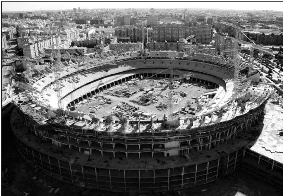
Les obres del nou Mestalla han portat a la crisi institucional i econòmica que travessa el València CF
