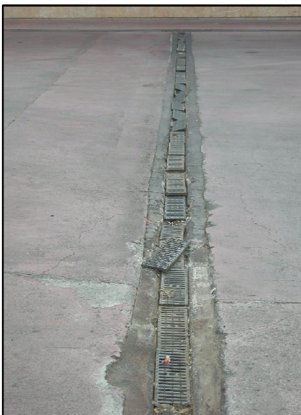
Estado en el que se encontraban las rejillas
