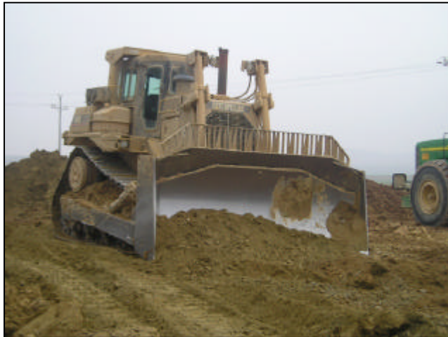
Les excavadores van obstuir el pou d'on treien l'aigua els habitants de Montagut.
