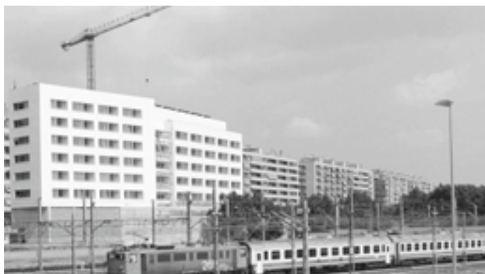
Vista dels nous pisos de la zona propera a les vies.
