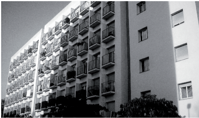
Edifici del carrer Tiana, on hi ha 6 famílies ocupant.
